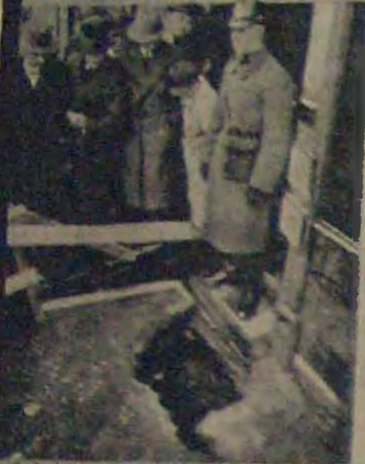
Aufhebungsbauwerk Eisenbahn in Berlin
